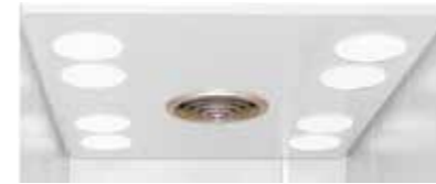
天井既存例 (化粧シート貼付)
