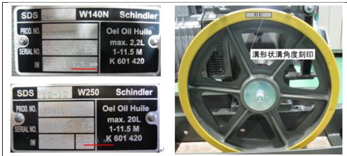
図 1-3b 綱車ロープ溝形状表記
