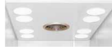
天井既存例 (化粧シート貼付)
